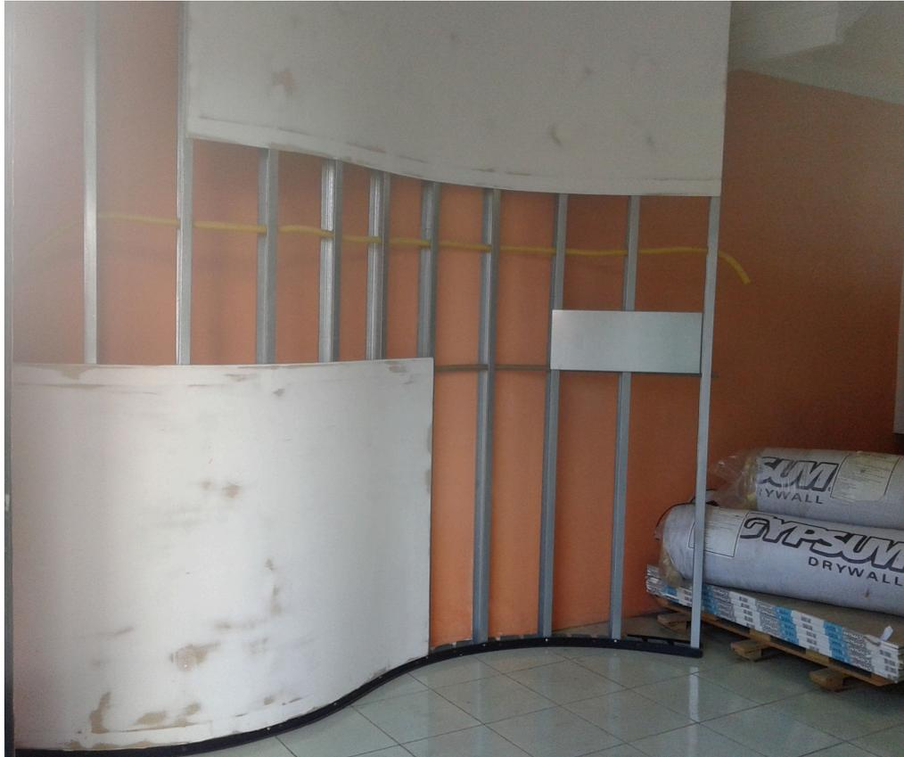
*Figura 13- Parede de Drywall
