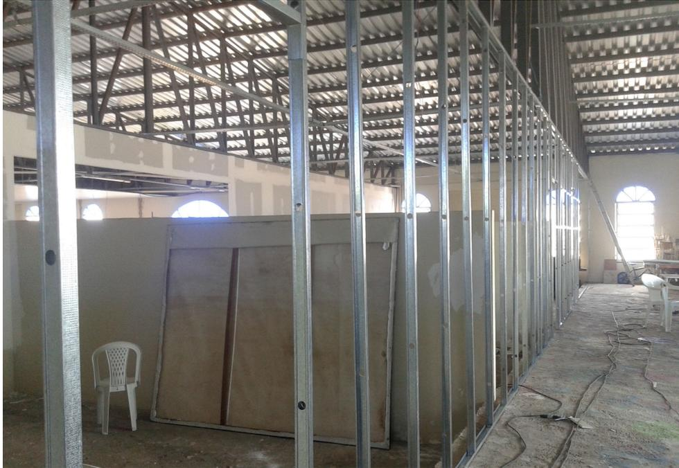
*Figura 14- Estrutura de Aço Galvanizado*
