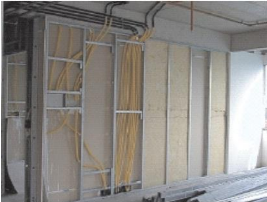
Imagem 8 – Instalações no drywall
