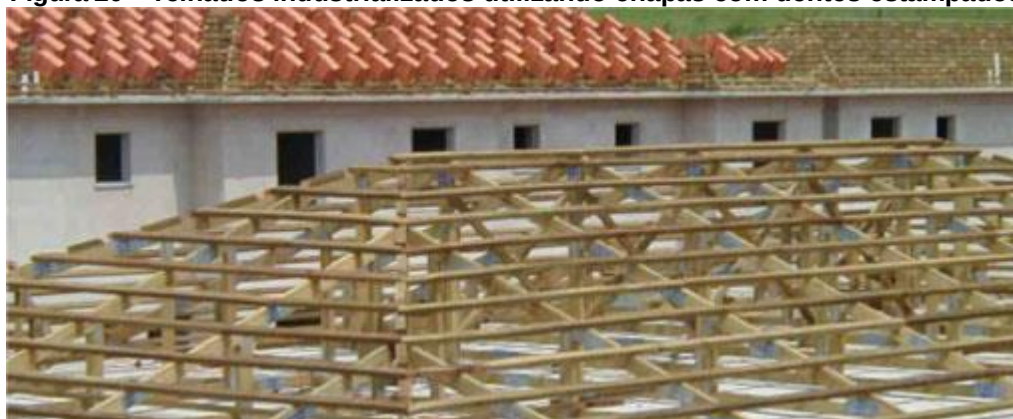
Figura 20 – Telhados industrializados utilizando chapas com dentes estampados
