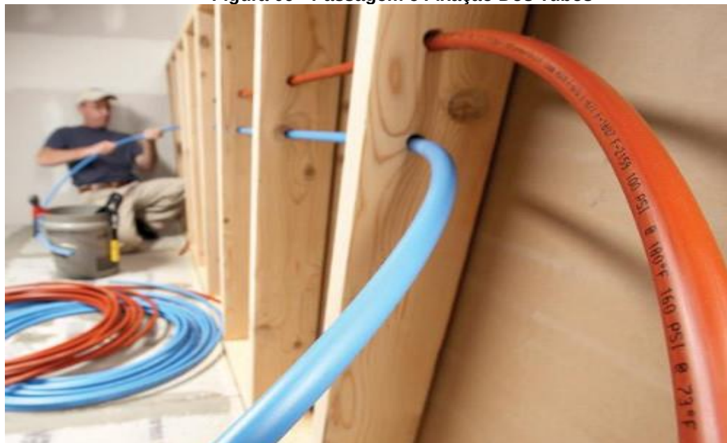
Figura 09 - Passagem e Fixação Dos Tubos
