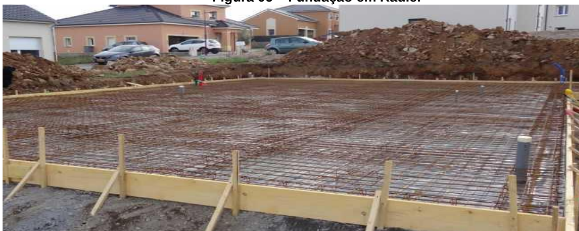
Figura 06 – Fundação em Radier
