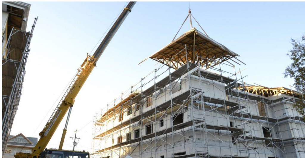
Figura 01: "Finalização da montagem do prédio em Wood frame da Tecverde em Araucária-PR."
