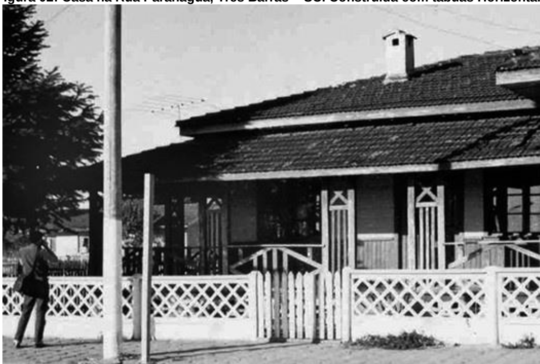
Figura 02: Casa na Rua Paranaguá, Três Barras – SC. Construída com tabuas Horizontais.
