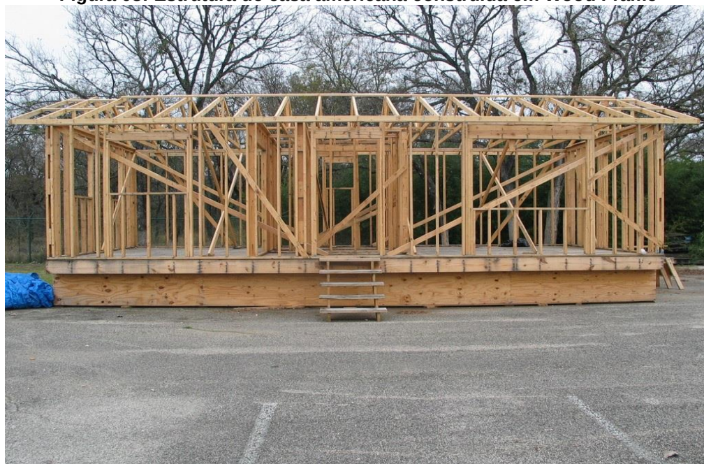
Figura 03: Estrutura de casa americana construída em Wood Frame
