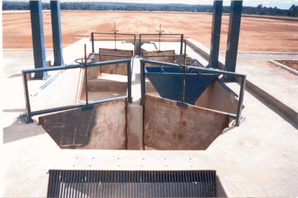
**Figura 50.** Fotografia de grade de barras, caixa de areia e calha Parshall.
