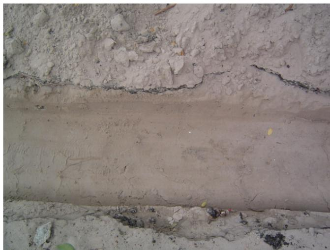
**Figura 115.** Escavação para o assentamento de um coletor
