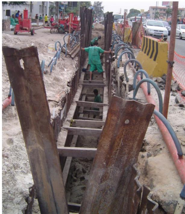
**Figura 119.** Escoramento de vala do tipo metálico-madeira
