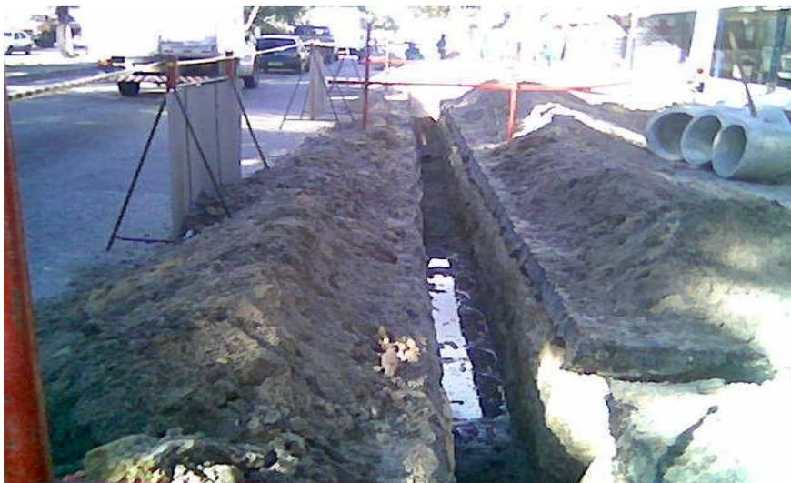
**Figura 104.** Exemplo de sinalização de obra para assentamento de tubulações
